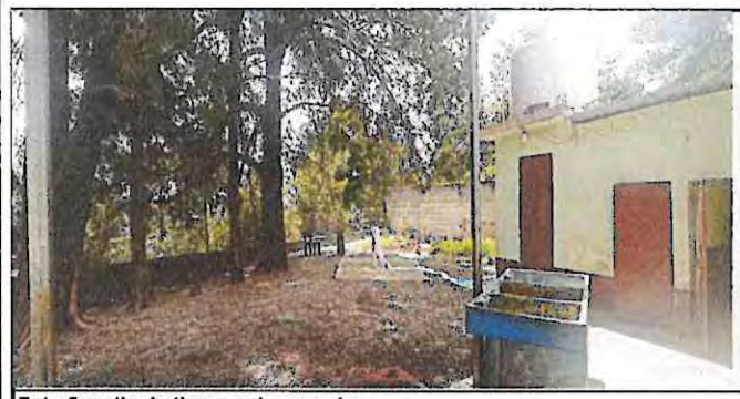
Foto 5: patio de tierra en la escuela
