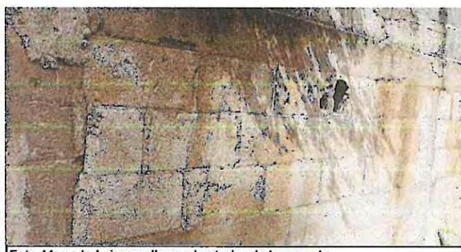
Foto 11: pared sin repello en el exterior de la escuela
