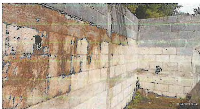
Foto 9: pared exterior de la escuela
