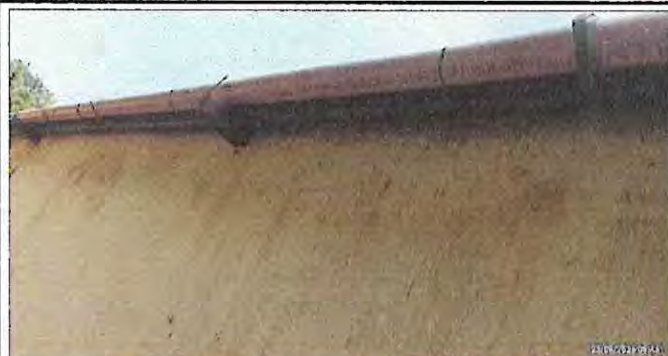
Foto1: canal de escuela en la parte exterior.
