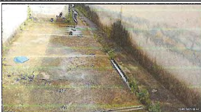
Foto 8: patio de cemento exterior de la escuela
