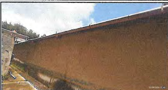
Foto13: Pintura exterior de la escuela
